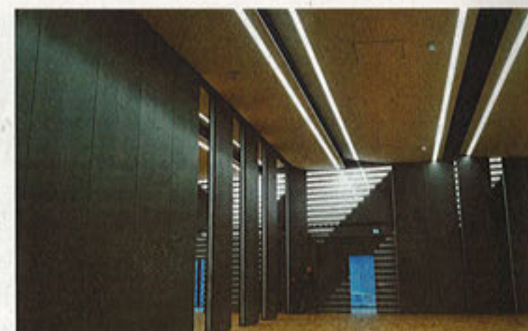
Werkplanung, Konstruktion, Herstellung sowie Installation aller verfahrenbaren Trennwände (Produkt: Steurer Copar 106) im Raiffeisen Multifunktionszentrum in Raaba. Trennwandkonstruktion hochschalldämmend mit schallabsorbierendem Aufbau (ø 0,5 mm mikroperforierte Breitbandabsorber der Projektpartner Egger und akustik+).
