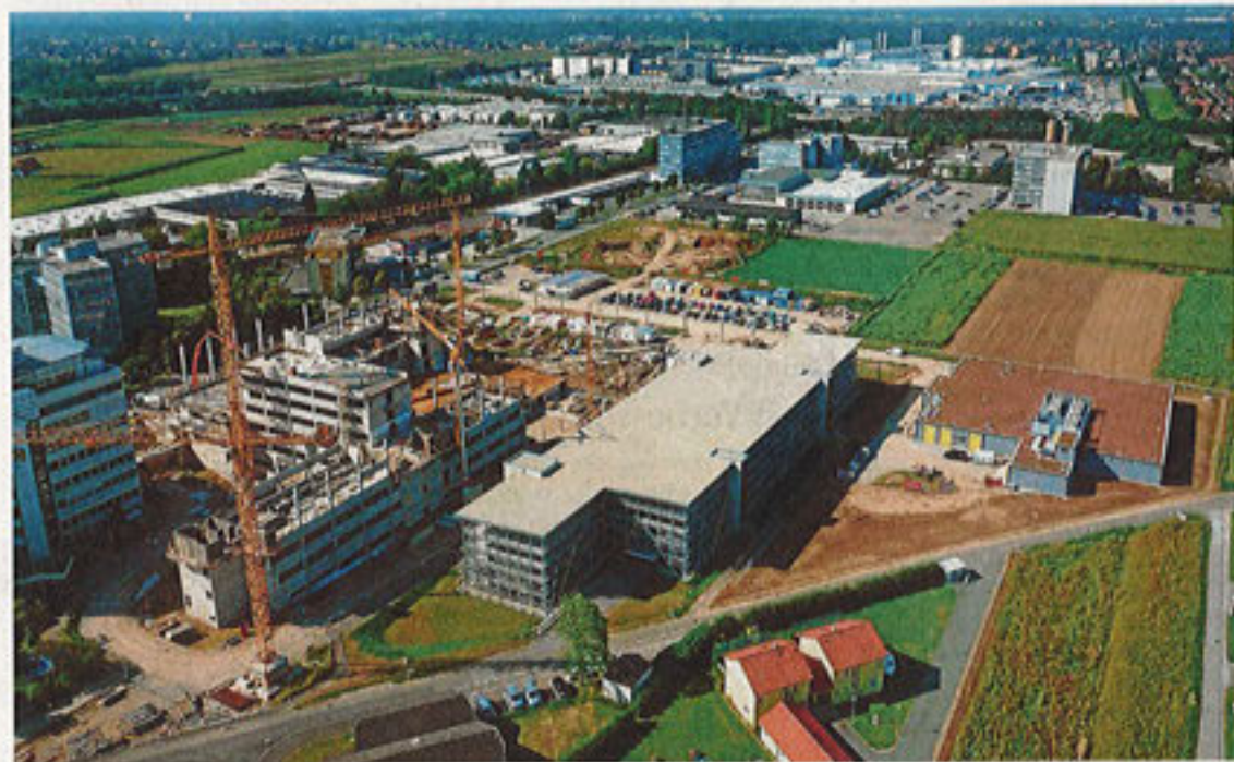
Bau. Der Neubau in Raaba umfasst das Bankgebäude, die Rechenzentrum-Systemräume sowie eine Hochgarage mit 640 Pkw-Stellplätzen auf einer Bauplatzfläche von 37.323 m 2 . Das Raumprogramm umfasst 40.840 m 2 .
